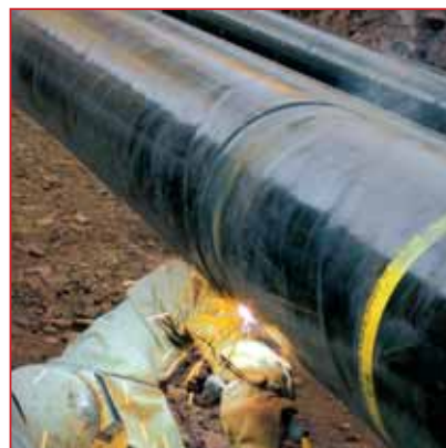
Wir verfügen über die Zulassungen nach DVGW Arbeitsblatt GW 301. Unsere Schweißer sind geprüft nach EN 287, Teil 1.
