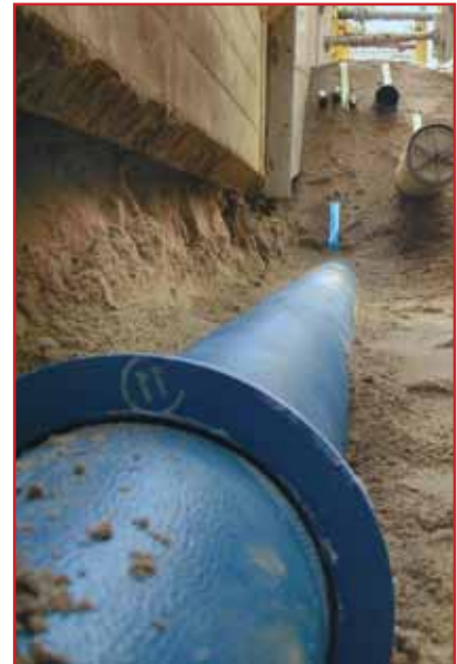
Alle Gewerke aus einer Hand: Spartenübergreifender Leitungs- und Netzbau bei Frankenluk für Strom-, Gas-, Wasser-, Fernwärme- und Kommunikationsnetze.
